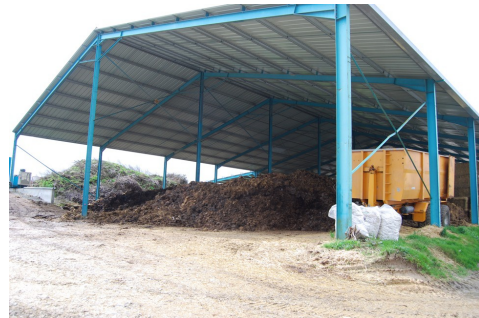
Stockage du fumier
